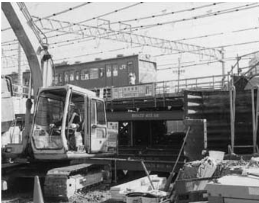
着々と進む囲護台踏切立体交差化工事
