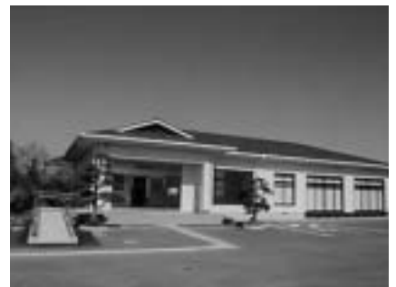
バリアフリーに配慮された西三里塚共同利用施設
