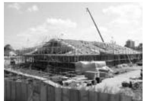
順調に工事が進む福祉センター
