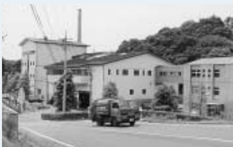
リサイクルプラザ(手前2棟)と いずみ清掃工場(写真奥)
