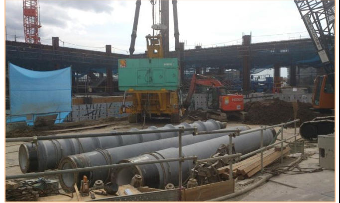
B棟の基礎杭打設状況
