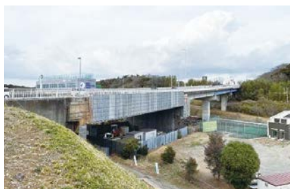
修繕工事中の郷部大橋
