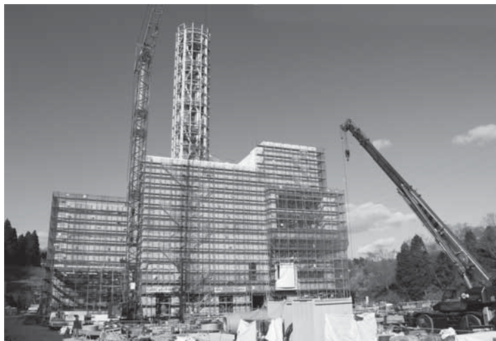
建設が進む新清掃工場
