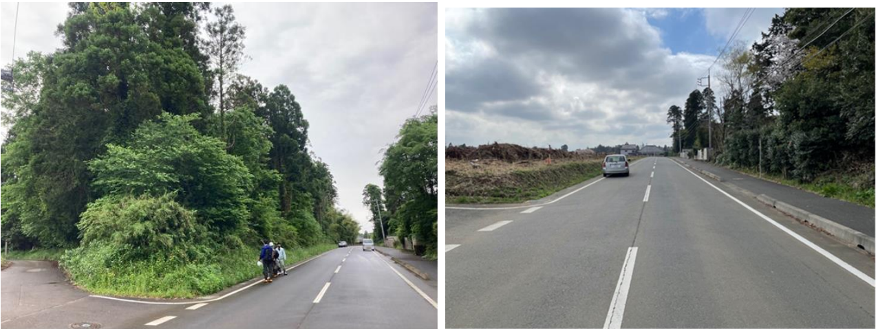
重要インフラ施設周辺森林整備事業（左が整備前、右が整備後） (重点的取組⑥関係)
