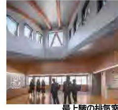
最上階の排気窓
