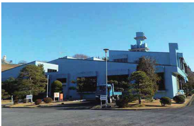
写真：成田浄化センター
