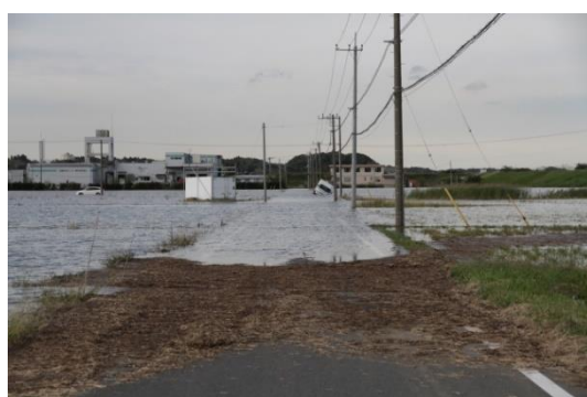
大型台風における本市被害時状況 (倒木・冠水)
