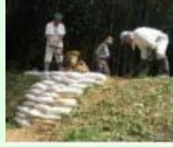
漏水箇所の補修
