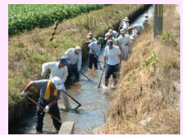
水路の泥上げ
