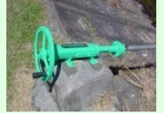
ゲート、バルブの更新
