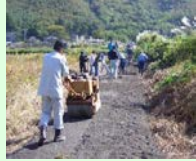
未舗装農道の舗装
