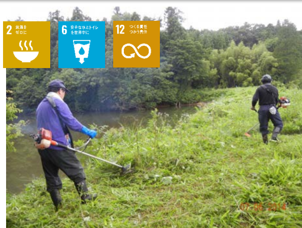
ため池堤体の草刈り
