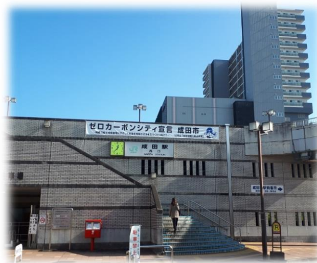
JR 成田駅西口へ横断幕を設置
