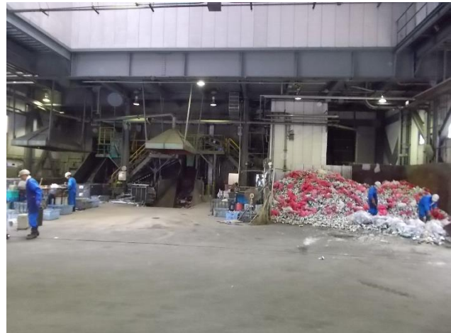
写真：成田市リサイクルプラザ
