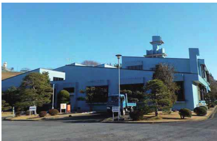
写真：成田浄化センター
