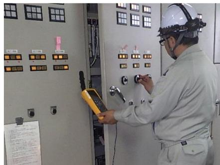
写真 6.1.1 計装設備の定期点検
