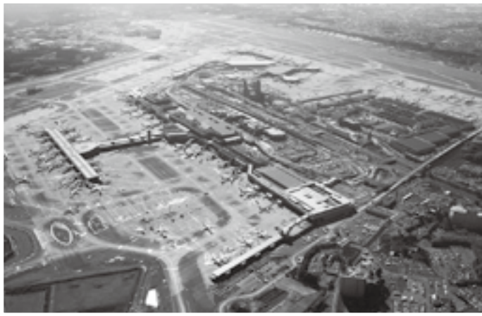
⑤上空から見た現在の第1ターミナル
