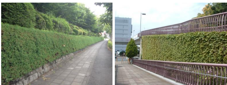
▲ボリューム感のある緑で擁壁を感じさせない工夫をしている。【②】
