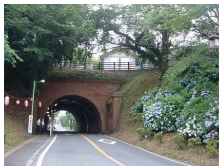
▲レンガ造りのトンネル。自然素材の持つ色合いが、経年変化により風合いを増している。【②】
