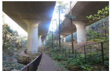
▲ 橋脚と桁の接合部を曲線的な仕上げとし、圧迫感の軽減に配慮されている。【①】
