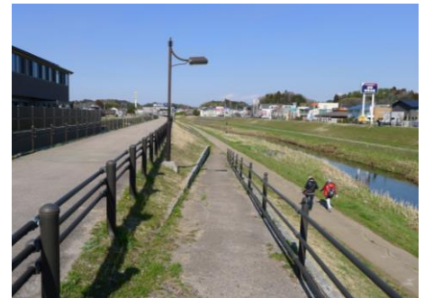
▲河川景観に配慮し、落ち着いた色彩の転落防止柵と街灯が設置されている。【④】
