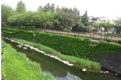
▲垂直護岸をつる性植物で緑化することで、人工的な印象を和らげる工夫がされている。【①】
