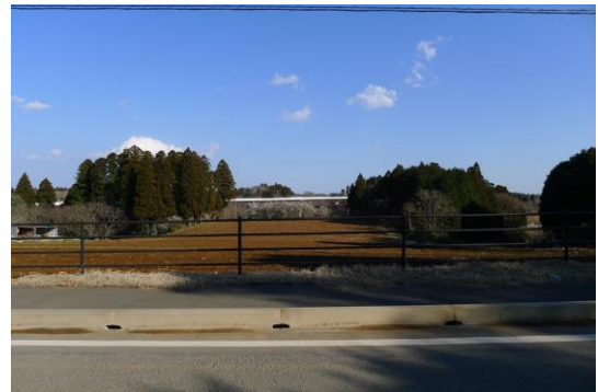
▲暗い色彩の防護柵は、一般的に景色に溶け込みやすい。【㊟】
