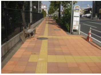
▲舗装の色が周辺から浮き出でてしまっている。また、誘導ブロックと舗装との輝度差が十分確保されていない。
