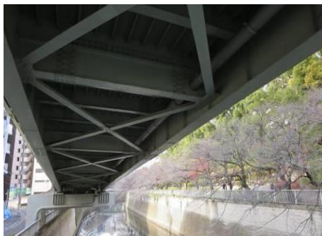
▲排水管を桁下に隠して、目立たない工夫がされている。【⑤】
