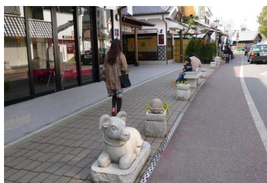
▲干支の動物をモチーフにしたポラード。道路の機能とは無関係なデザインだが、素材や色を車止めと合わせ、歩行者の視界を阻害していないため、周辺と調和している。【④】
