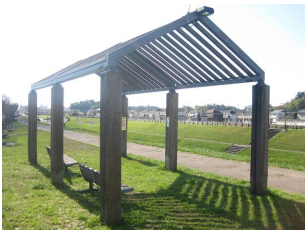
▲河川堤防に置かれた休憩施設。良好な視点場として、周辺の除草など適切な管理が求められる。【②】
