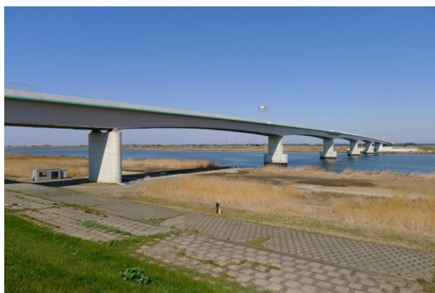
▲利根川に架かる道路橋。曲線処理された桁の形状と、シンプルな色彩の中に一部強調されたラインが、周辺の河川景観に調和した軽快でさわやかな印象を与えている。
