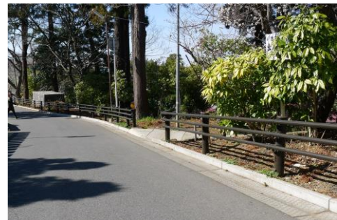
▲社寺に隣接する公道。落ち着いたシンプルな防護柵が周辺に調和している。【④】
