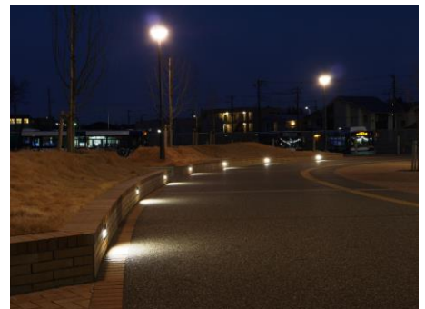
▲植栽帯の壁面に照明施設を配置し、安全性と夜間景観の演出が両立されている。【⑥】
