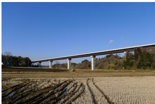
▲谷津に架かる道路橋。背景の谷津の景観に対し、シンプルで程良い規模とすることで、違和感が少ない。(グランドスケール)
