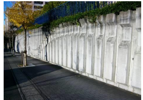
▲ 長い擁壁面について、分節化やスリット、連続する曲線のデザインが工夫され、壁面の単調さや圧迫感の軽減が図られている。【②】
