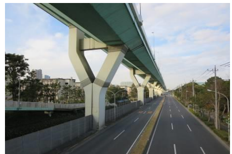
▲ Y型の橋脚により、橋下空間がすっきりとした印象となっている。【①】
