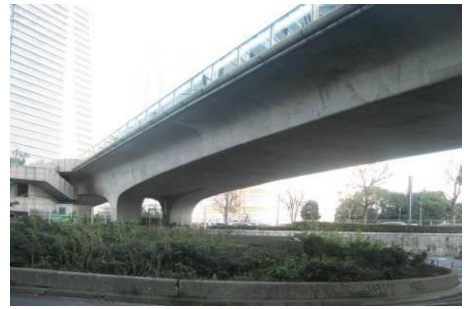
▲ 桁と橋脚を柔らかい曲線の仕上げとし、圧迫感の軽減が図られている。【①】
