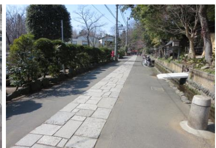
▲アスファルト舗装の一部に石畳を設けた例。経済性と良好な景観を両立している。【②】
