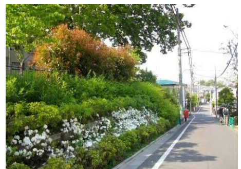
▲ 擁壁に緑化用ブロックを用いることにより、潤いや彩りづくりが図られている。【⑤】
