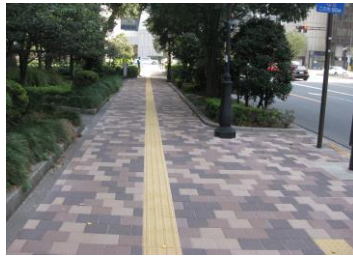
▲個々の舗装材の色合いをそろえることで全体的にまとまりのある舗装となっている。また、誘導ブロックと舗装との輝度差が確保されている。
