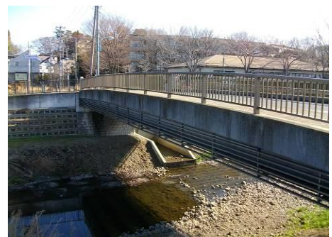
▲橋梁に付属する送水管がルーバーで遮へいされている。【⑤】
