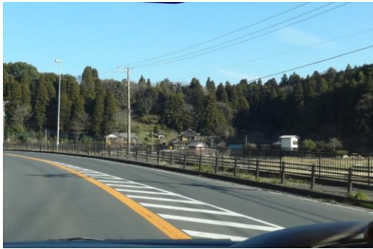
▲谷津への眺望を阻害しない道路付帯施設の色彩となっている。
