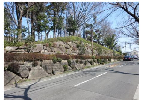
▲石積み擁壁の高さを分節し、一部緑化を施すことで圧迫感の軽減が図られている。【②】
