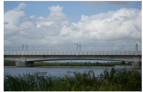
▲ 桁の形状をアーチ状とすることで、背景への見通しに配慮されている。【②】
