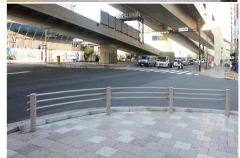
▲道路付帯施設や占用物のデザインが統一されている。【①】
