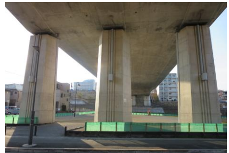
▲ 圧迫感を軽減するため、橋脚の面取りやスリット加工の工夫がされている。【①】
