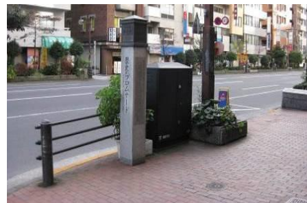
▲分電盤等の集約と通行を阻害しない配置の工夫がされている。【①】
