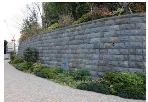
▲ 擁壁をセットバックし、そのスペースに植栽を施すことにより圧迫感の軽減が図られている。【②】
