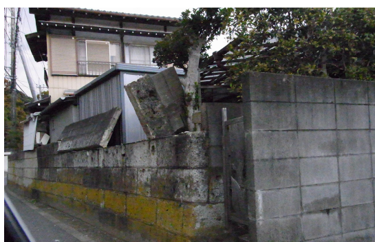
ブロック塀の崩れ（成田市土屋地内）
