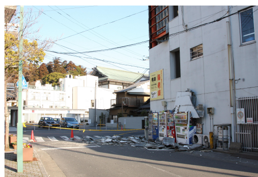
壁が崩落した建物（成田市本町地内）
