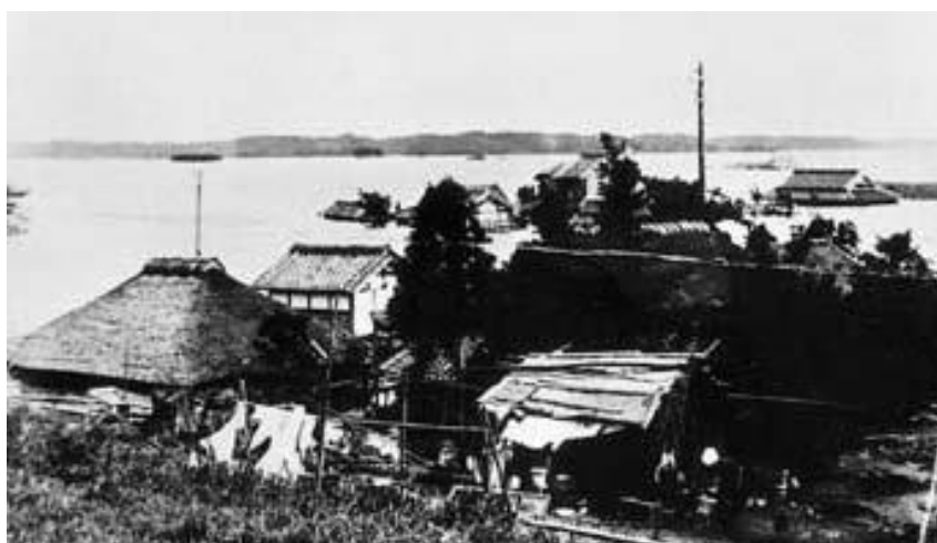
昭和16年7月、台風の上陸により根木名川が決壊し、安西地区は一夜にして家屋が水没した。
