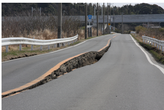
路面が大きく隆起した甚兵衛大橋
