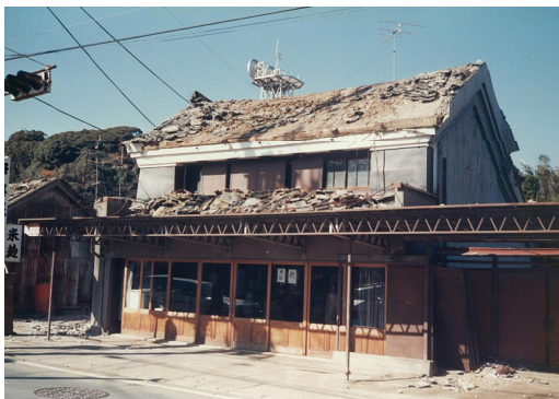
屋根瓦の崩落(東金市)
