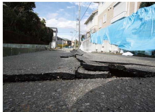
隆起した道路（成田市中台地内）
