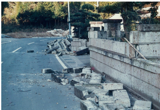
石塀の被害(長柄町)
