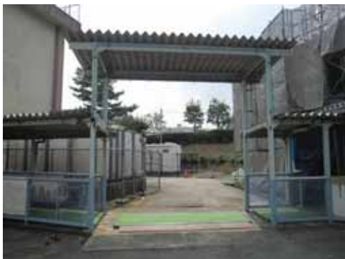
配膳室への車路となっている渡り廊下
