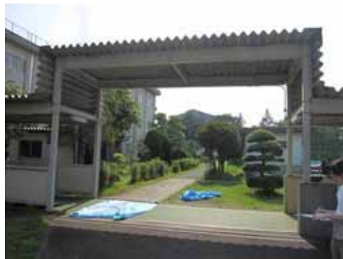
校舎から屋内運動場への渡り廊下
