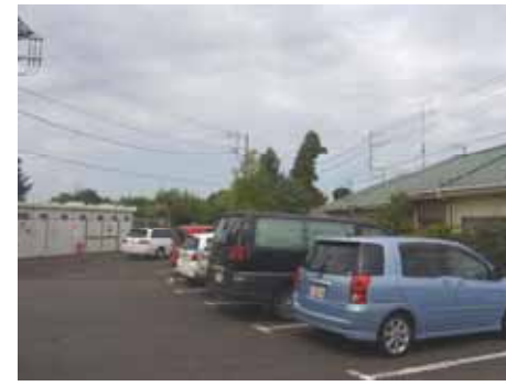
既存キュービクルと駐車場
