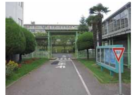
配膳室への車路となっている渡り廊下
