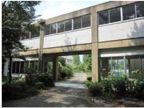
配膳室へ続く車路
