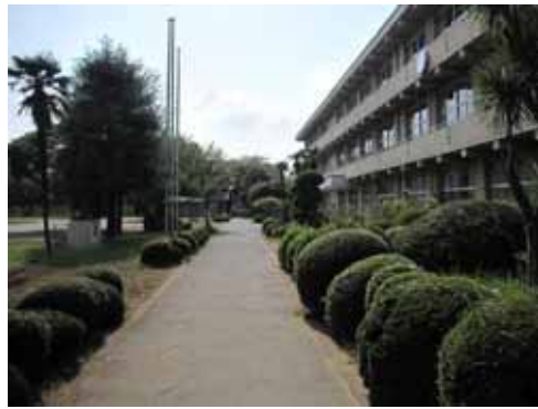
校舎南側通路
