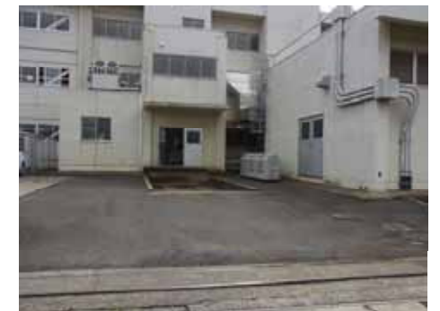
機械室と駐車場
