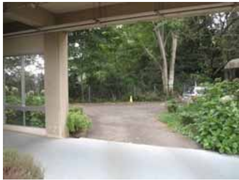
車路となっている渡り廊下
