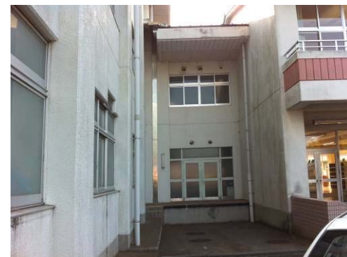
④既存配膳室
