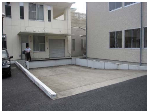
④既存配膳室
