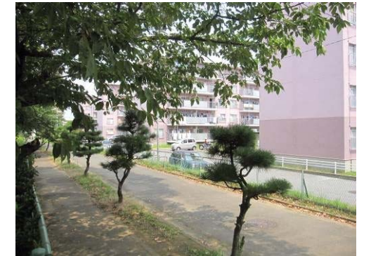
⑧敷地東側緑道
