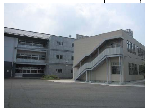
③仮設校舎
