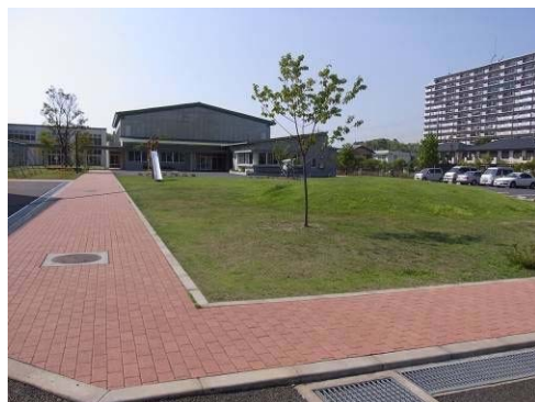
④校舎北側校舎増築スペース
