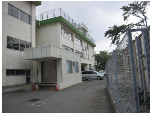
④既存配膳室
