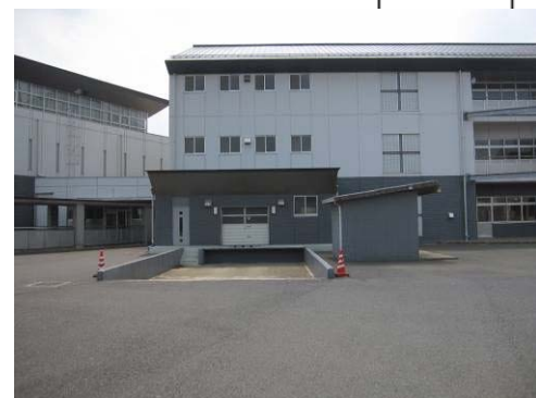
④既存配膳室
