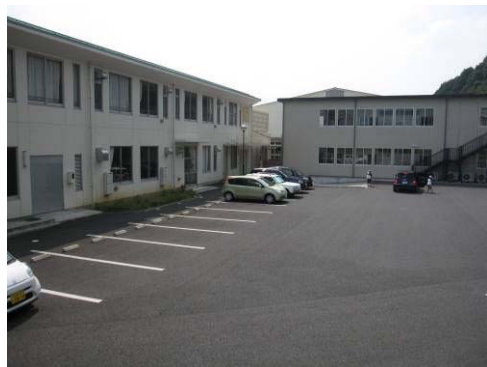
③校舎西側駐車場
