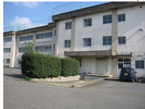
③既存配膳室
