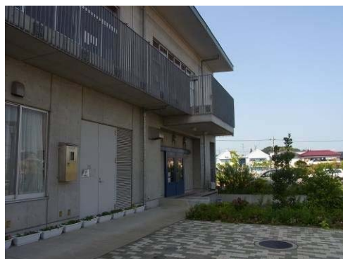
③既存配膳室
