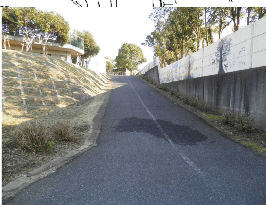
⑦西側の裏門南側通路
