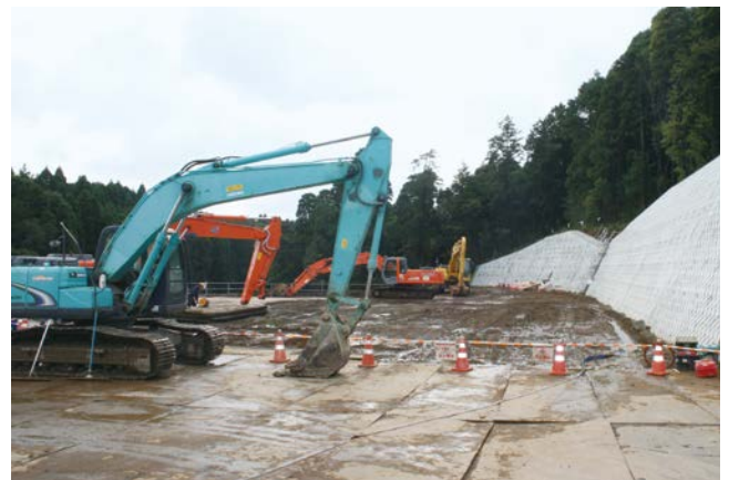
工事が進む並木町調整池
