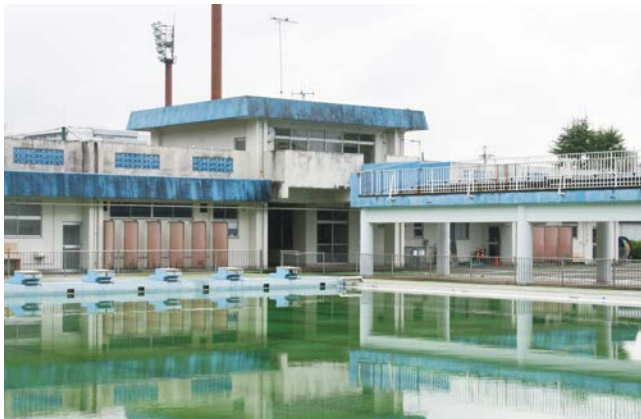
改修が予定される中台プールと管理棟
