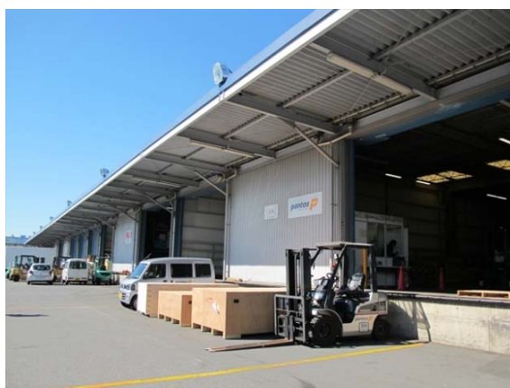
屋外搬出入スペース（高床式接車バース GL+1m）
