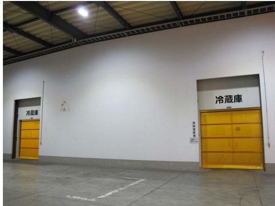
冷蔵庫・冷凍庫前室
