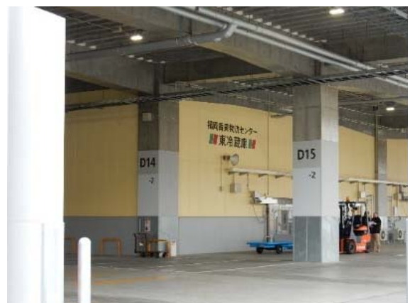
事業者整備冷蔵庫
