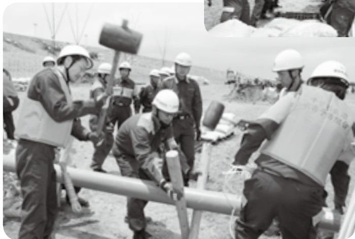
漏水箇所から水を排出するパイプを固定
