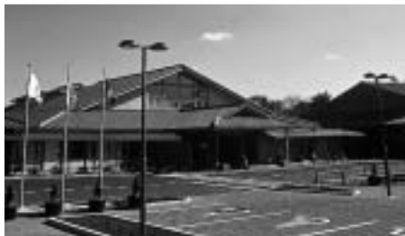
完成した保健福祉館(平成14年7月)
