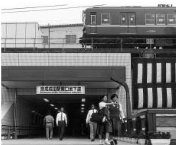
開通した京成成田駅東口地下道（平成4年7月23日）
