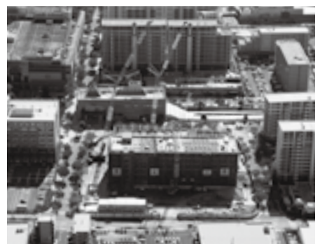
医学部建設中の様子(平成28年10月)
