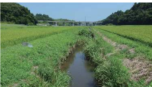
田んぼの上を東関東自動車道が横断している
