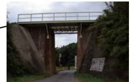
レンガの外装が目立つ 跨道橋
