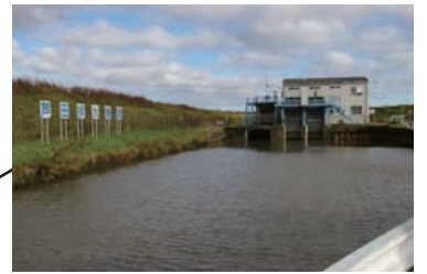
芦田排水機場
