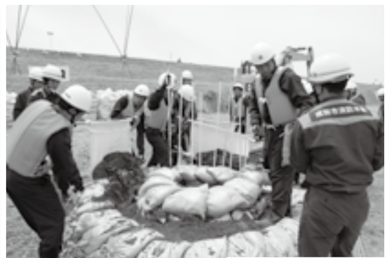
堤防の漏水には「釜段工法」で対処
