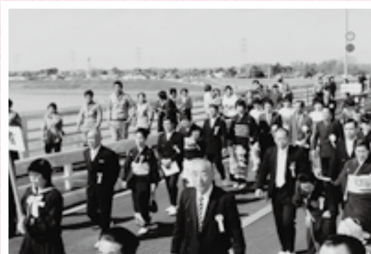
常総大橋が完成 (昭和54年)
