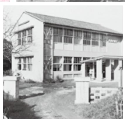
下総町役場が完成(昭和31年)
