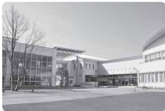
③増築された校舎(虹の校舎)
