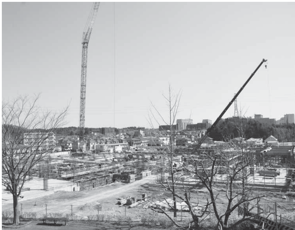
建設工事が始まった公津の杜中学校
