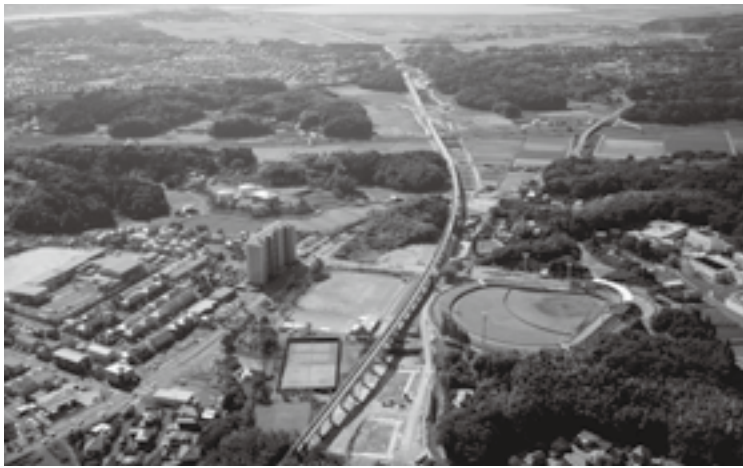
開業を平成22年度に控える成田新高速鉄道
