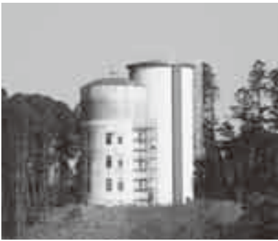
後方が新しい高架水塔
