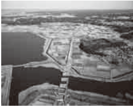
建設が進む「成田新高速鉄道」
