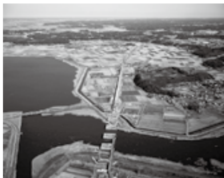
建設が進む「成田新高速鉄道」
