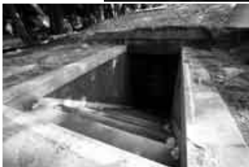
内部へ階段が続く防空壕入口
