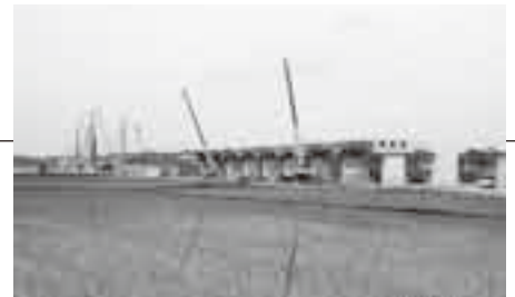
建設の進む成田新高速鉄道(北須賀地先)
