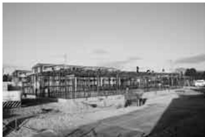
5月開校に向け、建設が進む生涯大学校
