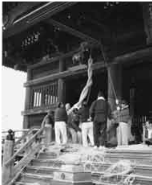
昨年の大注連縄の張り替え作業
