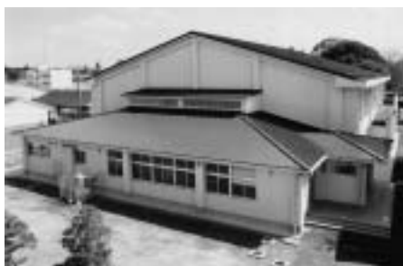
完成した新体育館
