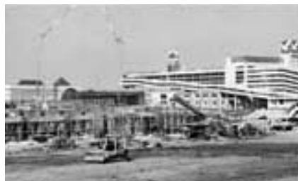
工事が進む公津の杜小学校
