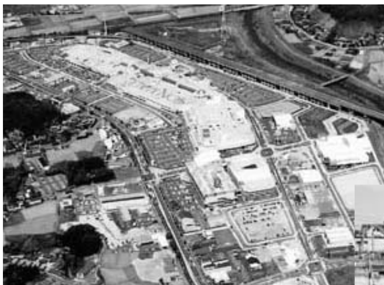
成田新高速鉄道の開通がもたれるウイング土屋地区
