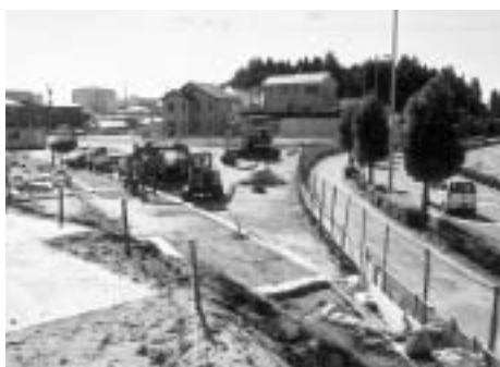
建設が進む郷部線(団護台方面)
