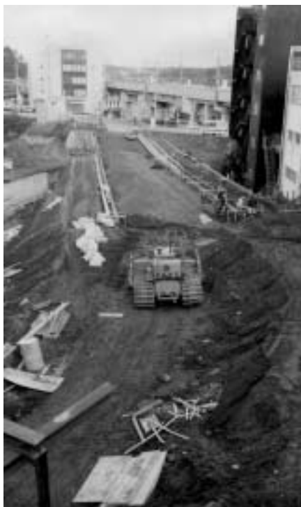
成田駅から国道51号線を結ぶアクセス道路の工事(昭和52年)
