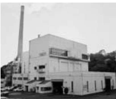
現在のいずみ清掃工場
