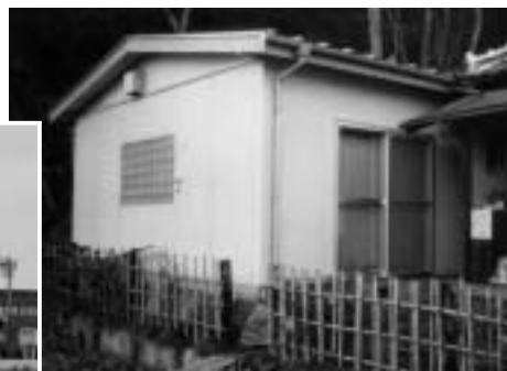
コンクリートプレハブ防音家屋
