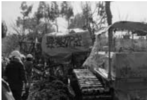
代執行による地下要さいの撤去作業 (昭和46年3月)
