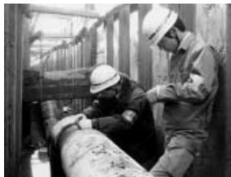
暫定パイプライン埋設の監視班
