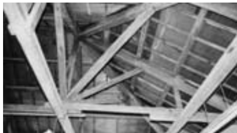
隔合掌造りと呼ばれる日本の伝統的な工法が見られる緬羊会館の内部
