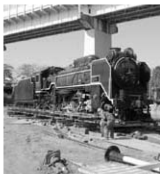
移設工事中のD51
